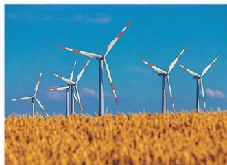
再生可能エネルギーを利用した発電（風力発電）
