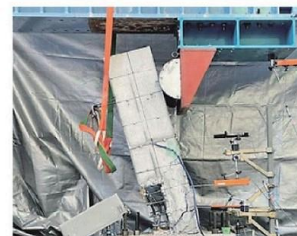
RC柱の解体実験の様子
