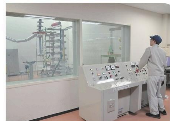
直流放電試験装置
